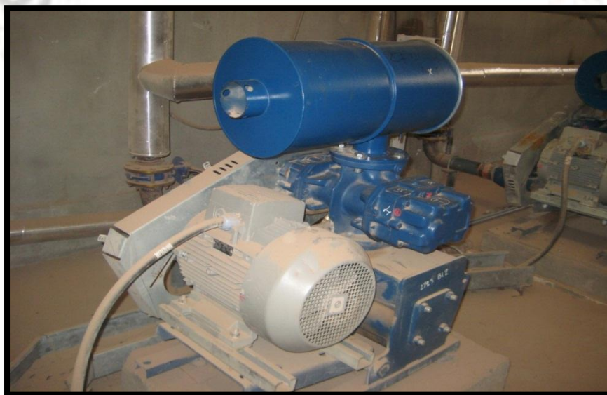
شکل شماره ۲- تصویری از بلور با سیستم انتقال قدرت تسمه و پولی
