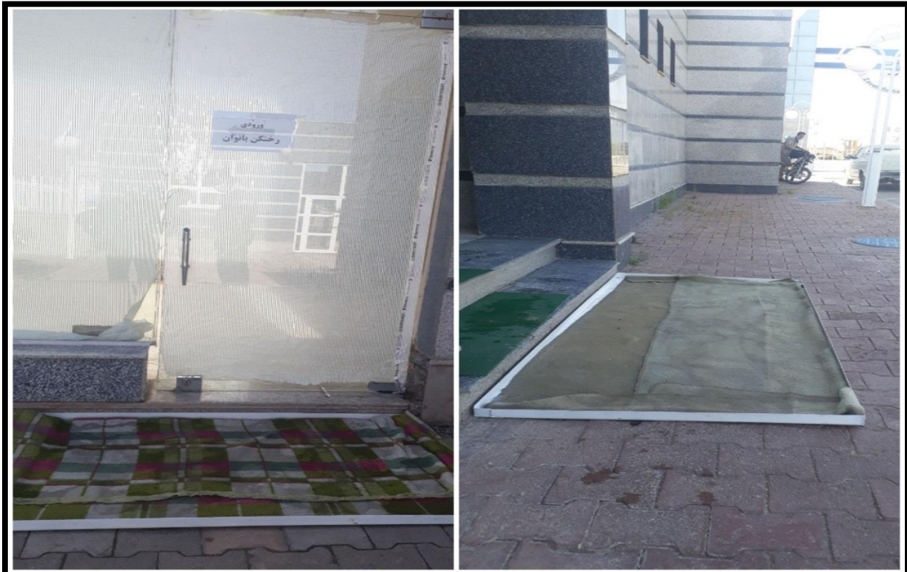
تهیه حوضچه ضد عفونی و نصب آن در ورودی کارخانه و رختکن پرسنل
