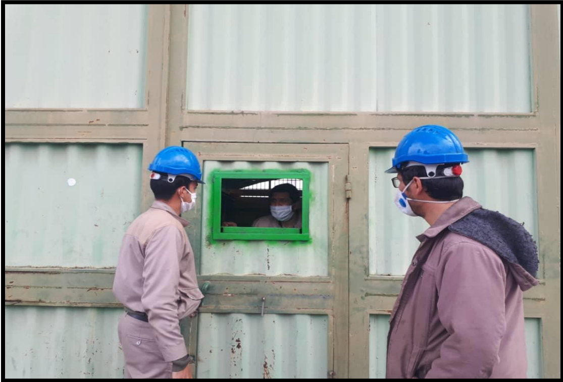
عدم اجازه ورود افراد به کارگاه
