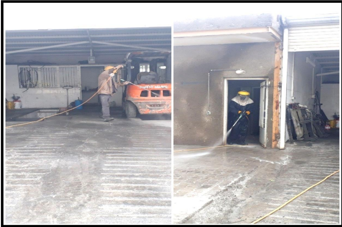
ضد عفونی تعمیرگاه لیفتراک‌ها و سرویس بهداشتی آنها
