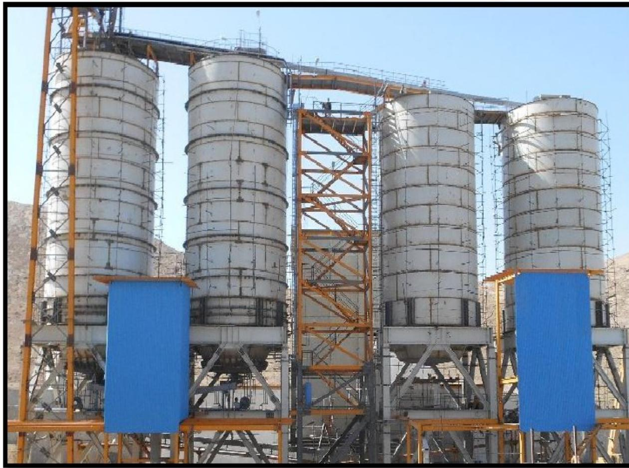
به منظور فراهم نمودن زیرساخت مناسب جهت افزایش تنوع محصول ، کاهش مصرف انرژی و افزایش سهم بازار خرید این سیلوها در جنوب سیلوهای بتونی خط تولید با امکان بارگیری ریلی، فله و پاکت در زمینی به مساحت ۵۵۰۰ متر مربع احداث شده است .
